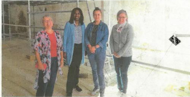
Bernadette Aubret, Marième Tamata-Varin, Suzana Demetrescu-Guénégo et Anne-Claire Hauduroy sont mobilisées pour la rénovation de l'église Saint-Martin de Yèbles. PVR/SM/77
