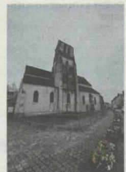
Plusieurs mesures ont été prises pour sécuriser le site. JLRSM77
