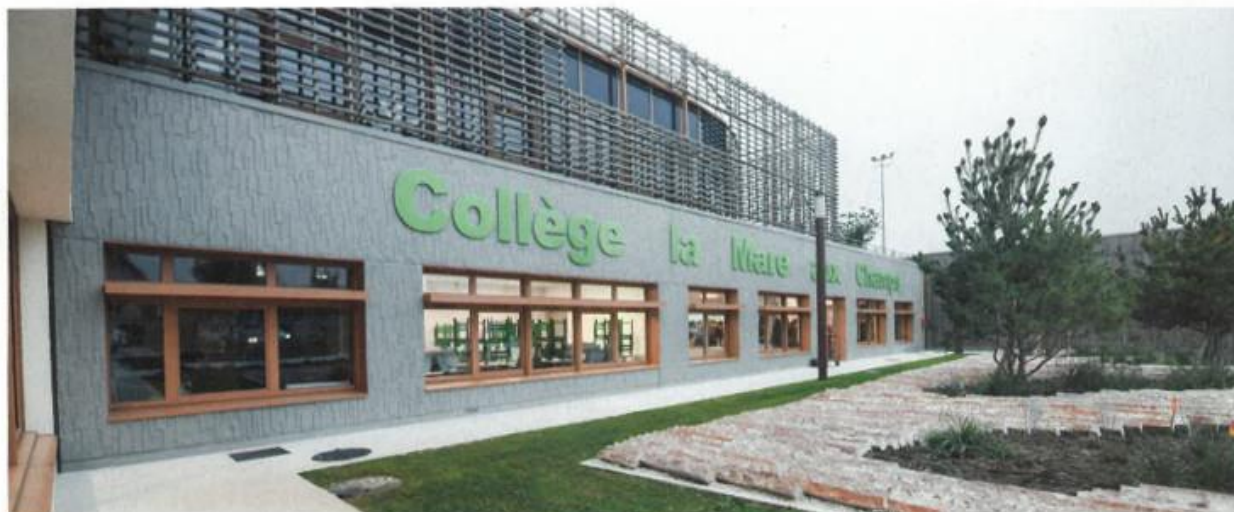
De 2019 à 2022, le collège La Mare-aux-Champs à Vaux-le-Pénil a bénéficié d'une reconstruction partielle et d'une rénovation importante des bâtiments existants.
