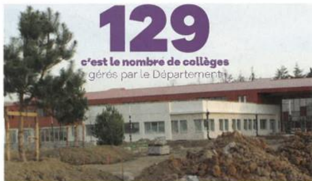
Le collège de Coubert en travaux. Ouverture prévue en septembre 2023.
